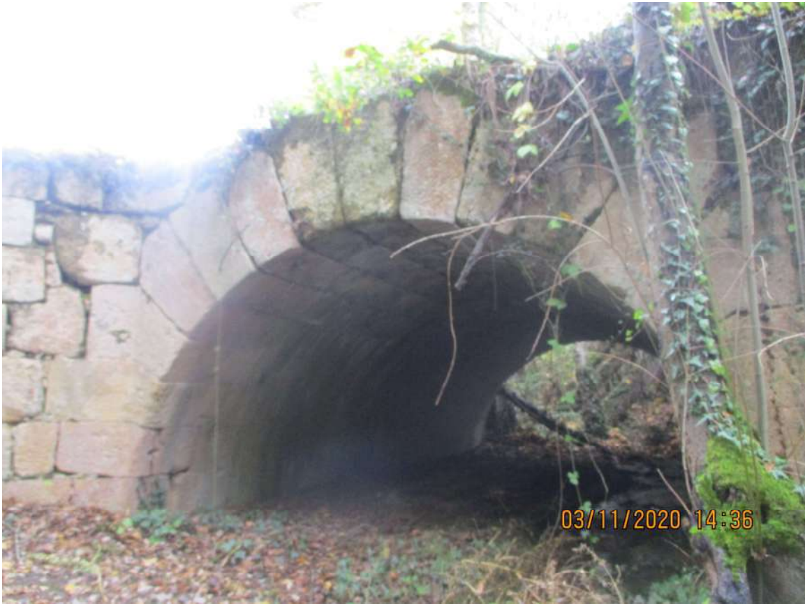
VISTA DEL ARROYO BAJO EL PUENTE
