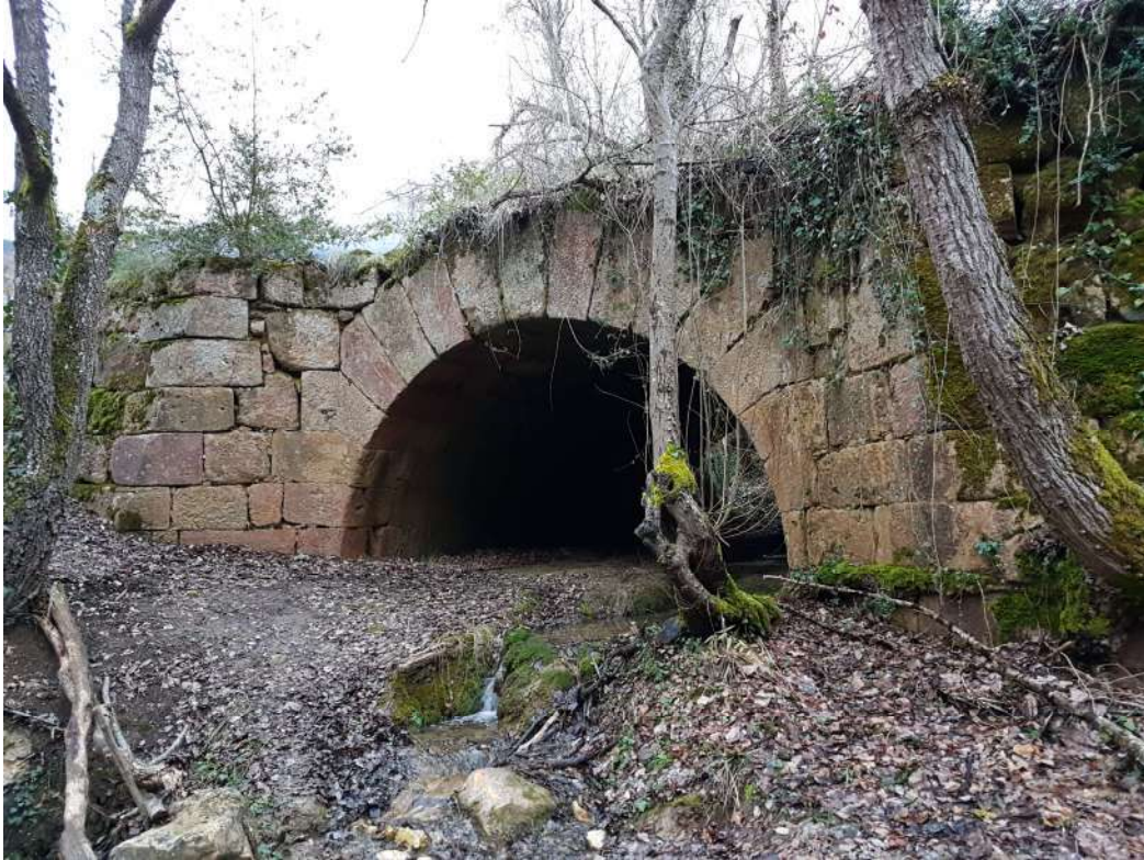
VISTA GENERAL DEL PUENTE AGUAS ABAJO
