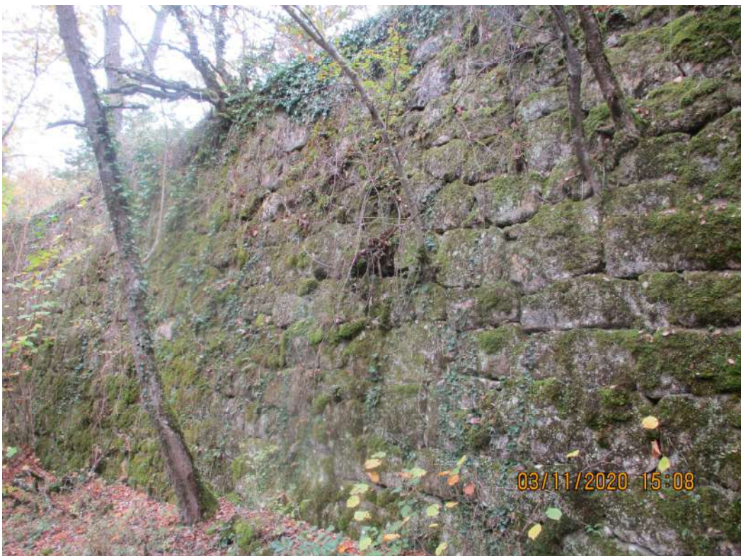
MURO DE SOSTENIMIENTO SEMIOCULTO POR LA VEGETACION Y MUSGO
