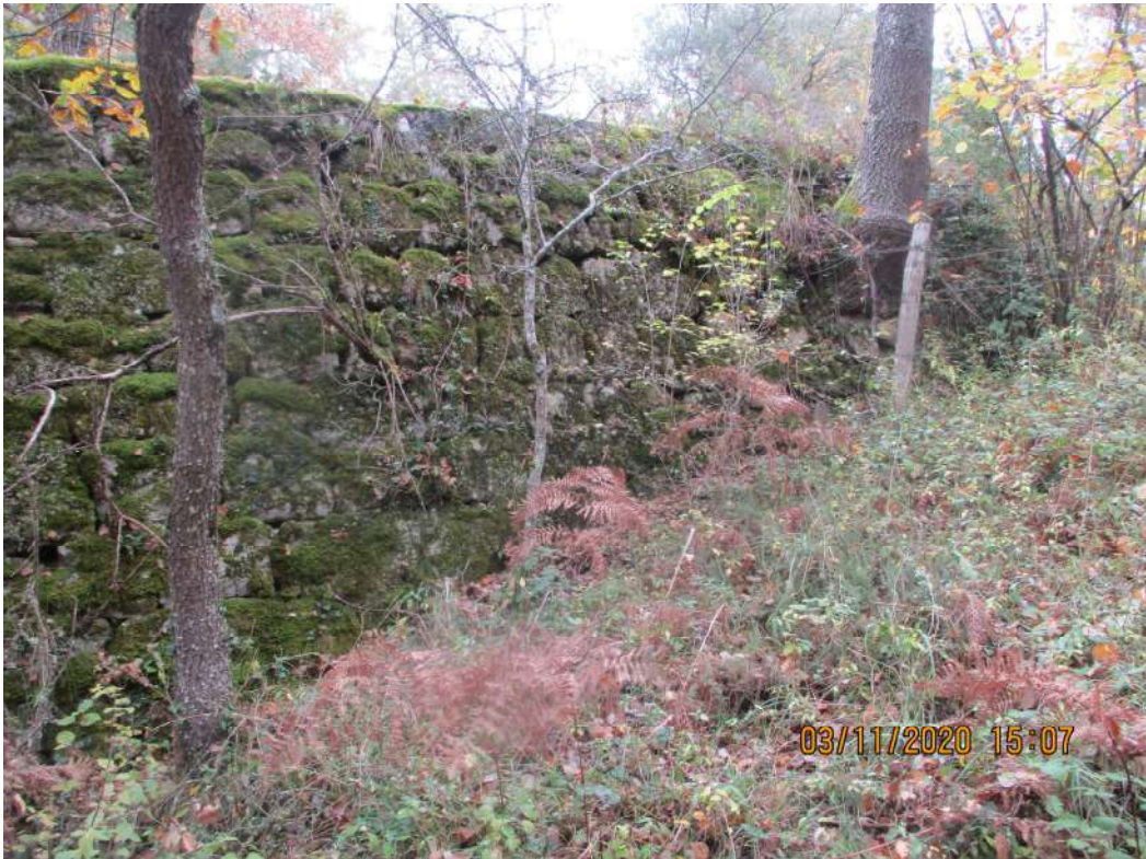
MURO DE SOSTENIMIENTO SEMIOCULTO POR LA VEGETACION Y MUSGO
