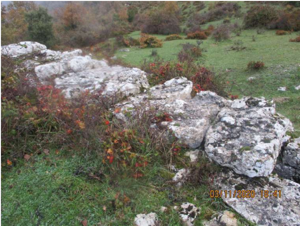
RESTOS ESTRUCTURA DE LA CALZADA
