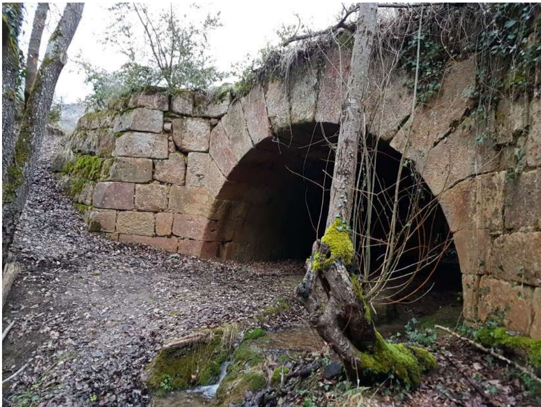
VISTA GENERAL DEL PUENTE AGUAS ABAJO
